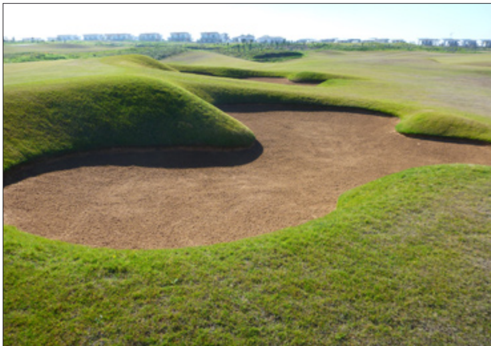
Zdjęcie 43. Wygląd bunkra piaszczystego świeżo po zakończeniu budowy.
