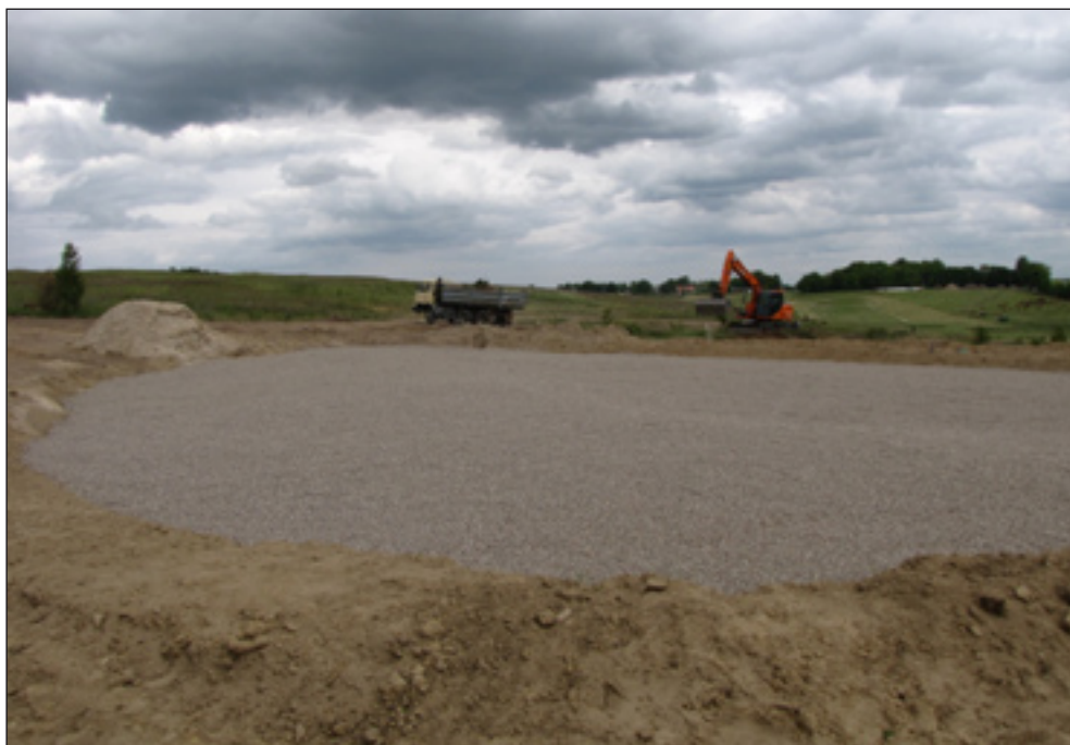
Zdjęcie 55. Wykonywanie podsypki żwirowej przy budowie greenu na polu w Tokarach.
