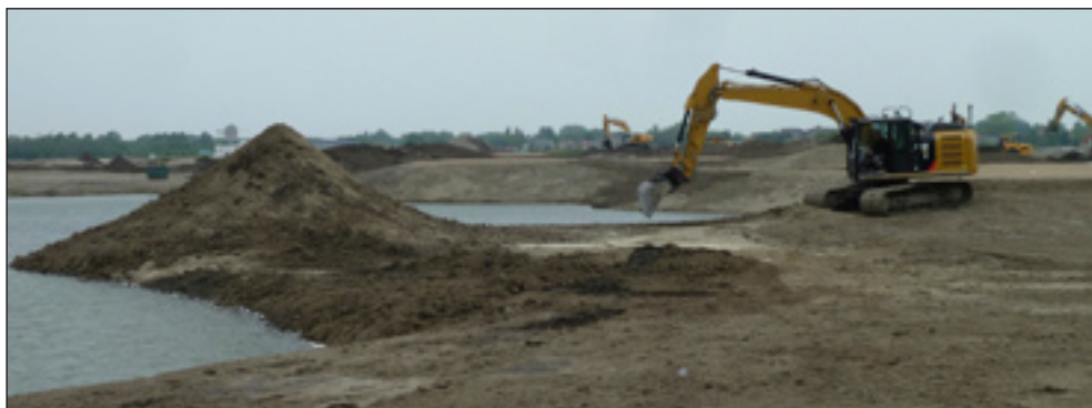
Zdjęcie 48. Prace ziemne na budowie pola Koksijde w Belgii.
