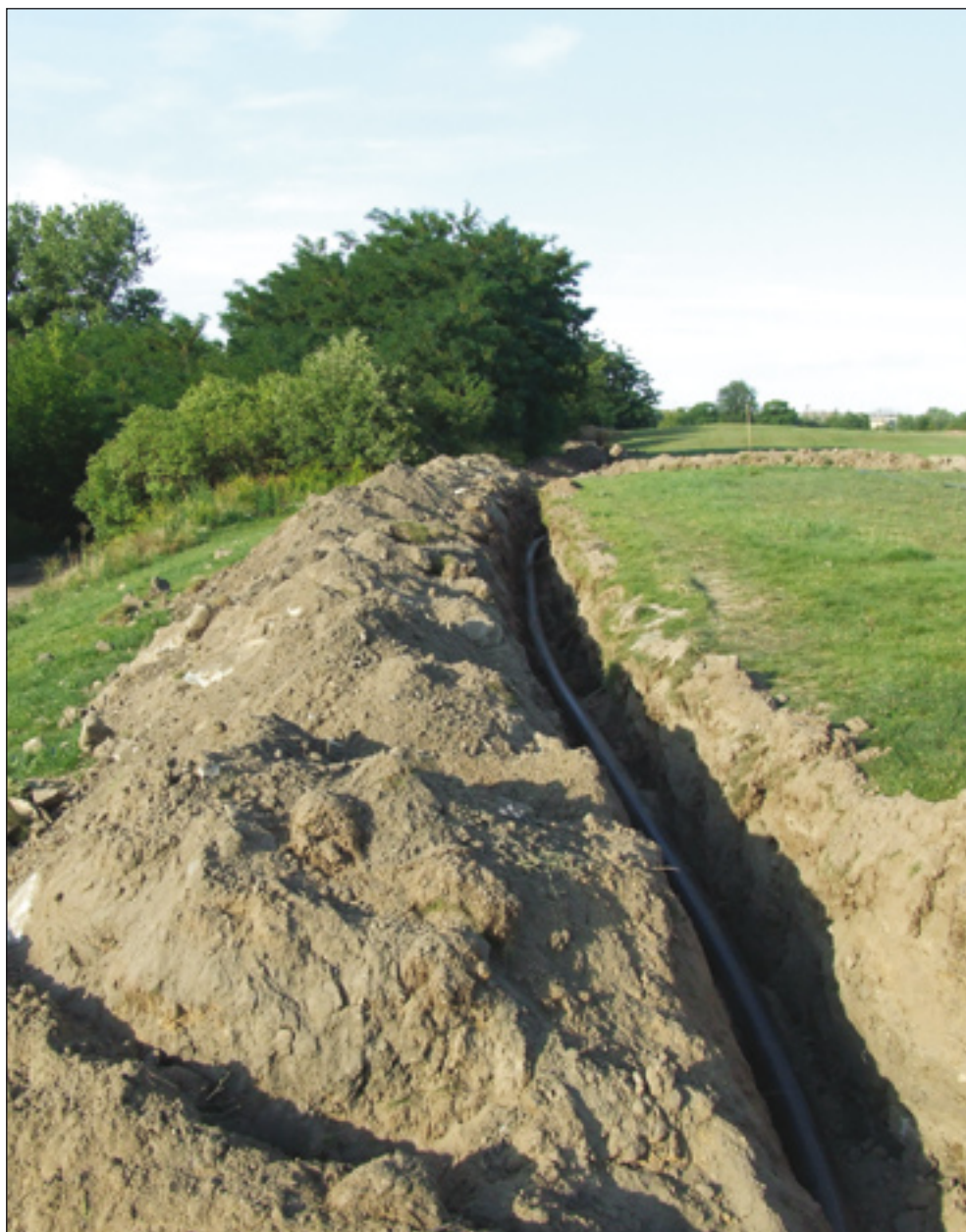
Zdjęcie 51. Rury instalacji nawadniającej ułożone w wykopanych rowach na budowie pola Zawarcie w Gorzowie Wielkopolskim.
