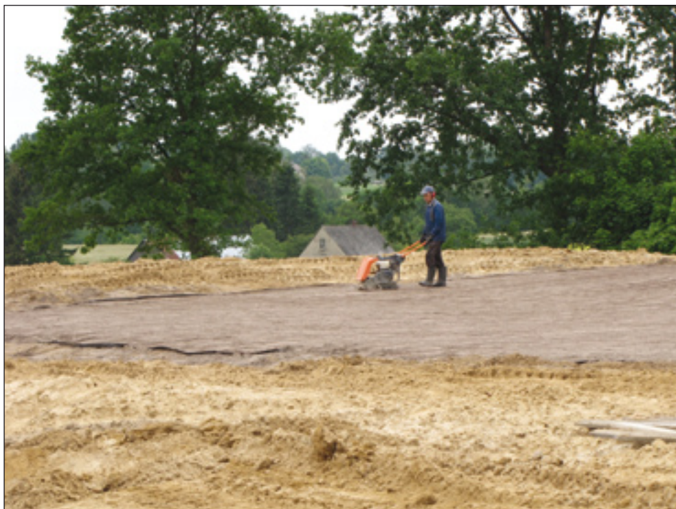
Zdjęcie 57. Ubijanie wierzchniej warstwy gleby przy budowie greenu, Tokary Golf Club.
