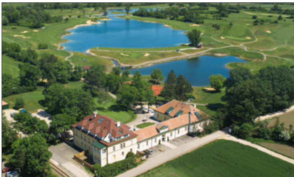
Zdjęcie 15. Wykorzystanie istniejących budynków na potrzeby domku klubowego i zaplecza technicznego na polu Diamond w Austrii.
