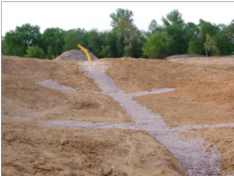
Zdjęcie 50. Ułożony drenaż fairwayu na budowie pola Toya pod Wrocławiem.
