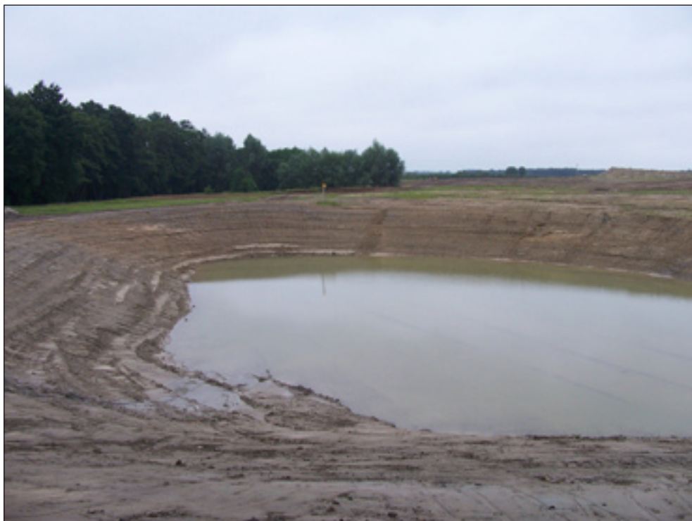
Zdjęcie 41. Jeden ze stawów o powierzchni 3 ha wykopany podczas robót ziemnych na budowanym polu Wejchert Golf Club.
