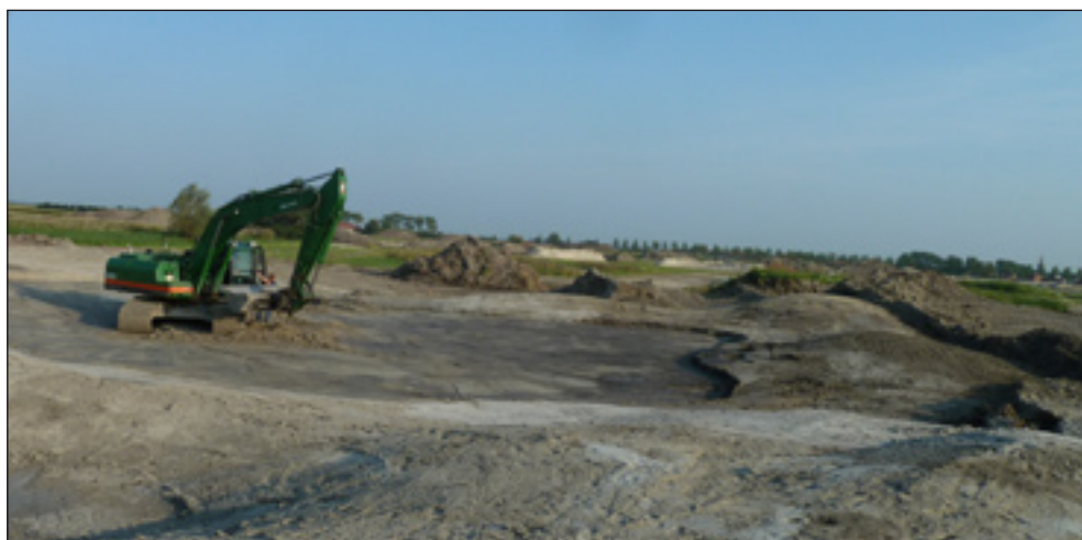
Zdjęcie 47. Usuwanie wierzchniej warstwy gleby na budowie pola Koksijde w Belgii.
