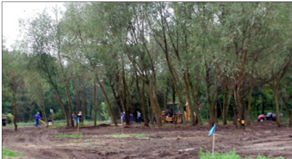
Zdjęcie 46. Oczyszczanie terenu na budowie pola Toya pod Wrocławiem.
