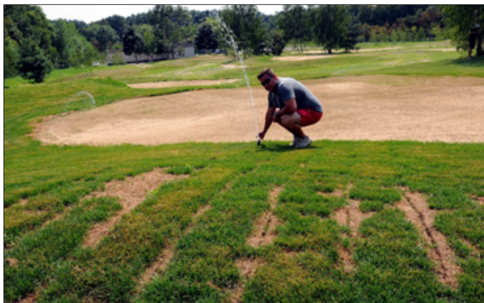
Zdjęcie 26. Budowa akademii golfa nad zalewem Zemborzyckim w Lublinie.
