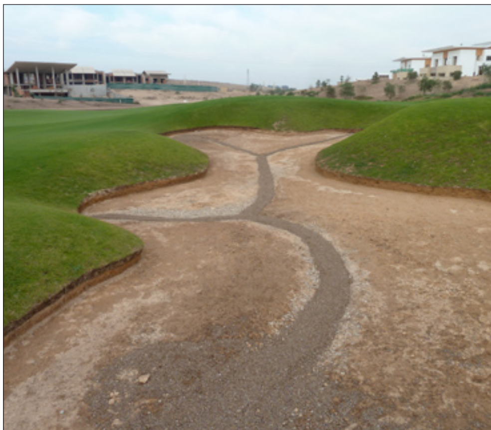
Zdjęcie 42. Położenie drenażu podczas budowy bunkra piaszczystego.
