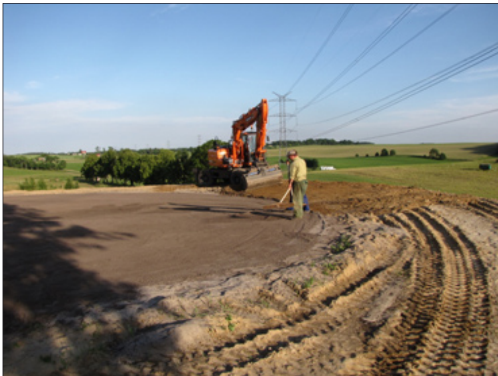
Zdjęcie 56. Układanie warstwy wierzchniej i równanie greenu, Tokary Golf Club.
